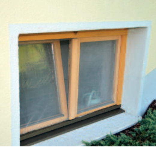
Abb. 2: Mit dem Anbringen von Insektengittern an Fenstern (links) und von Absperrbändern entlang der Hausmauer (rechts) werden die Diplopoden am Eindringen in die Häuser gehindert. Die ca. 8 cm hohen Absperrbänder werden oben mit einem doppelseitigen Klebeband an die Mauer fixiert. Das Material bietet keinen Halt, dass die Schnurfüßer auch dort wo die Bänder an der Wand anliegen nicht weiterkommen.
