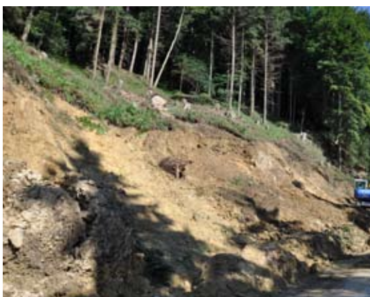
Sanierung der Pfänderstraße nach den Rutschungen im Sommer 2010.
