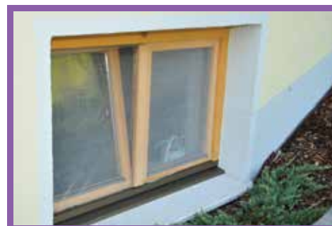
Abb 3 - Schutzgitter und Dichtungen (Foto: Klaus Zimmermann)
